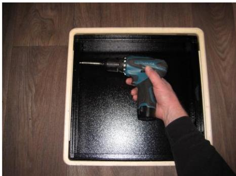
Den Tresor in das Bodenstauraufach einschieben. Tresor an den Distanzbrettern mit vier Schrauben 3,9x30 mm befestigen.
